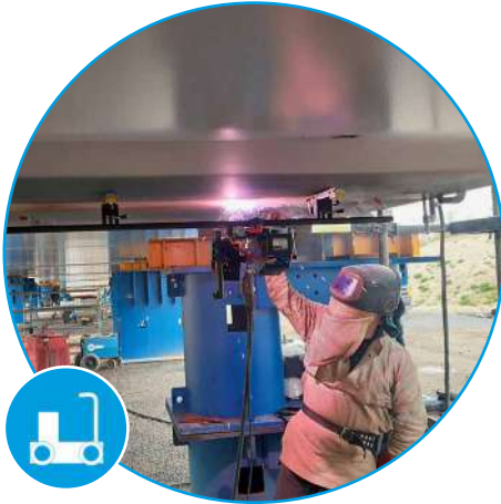
SERVIBOT - MÉCANISATION DU SOUDAGE
